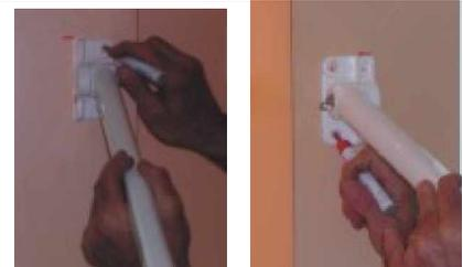
**7** Puis, réaliser le perçage (avec un foret pour vis M8) aux points marqués, et y insérer les chevilles pour la fixation des supports de bras.
